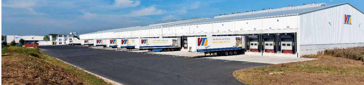
VTL-Hub in Fulda - Wirkungsstätte einer hoffnungsvollen Nachwuchskraft.
